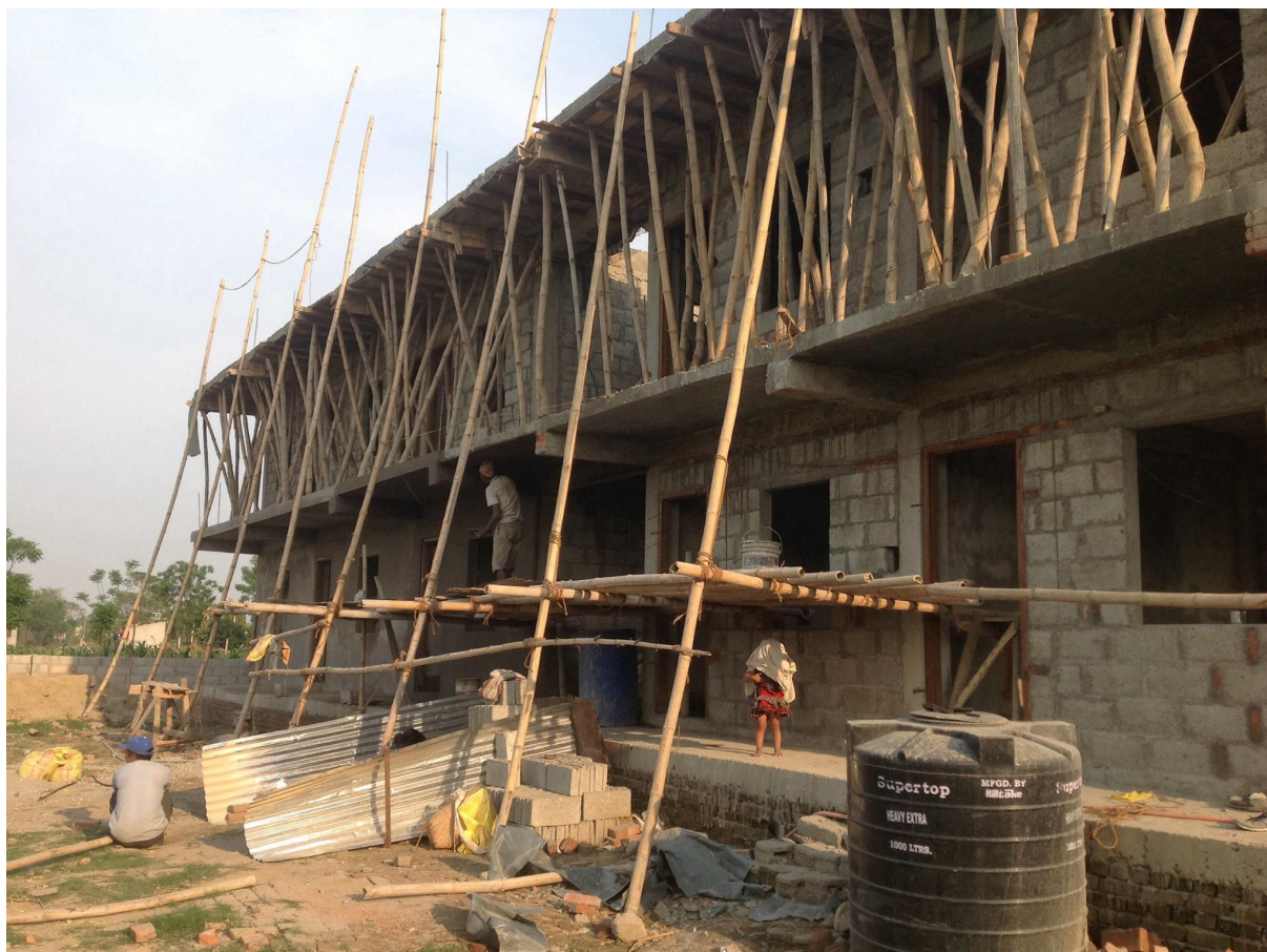
Echafaudage artisanal en bambou. Photo Pemba Sherpa©
