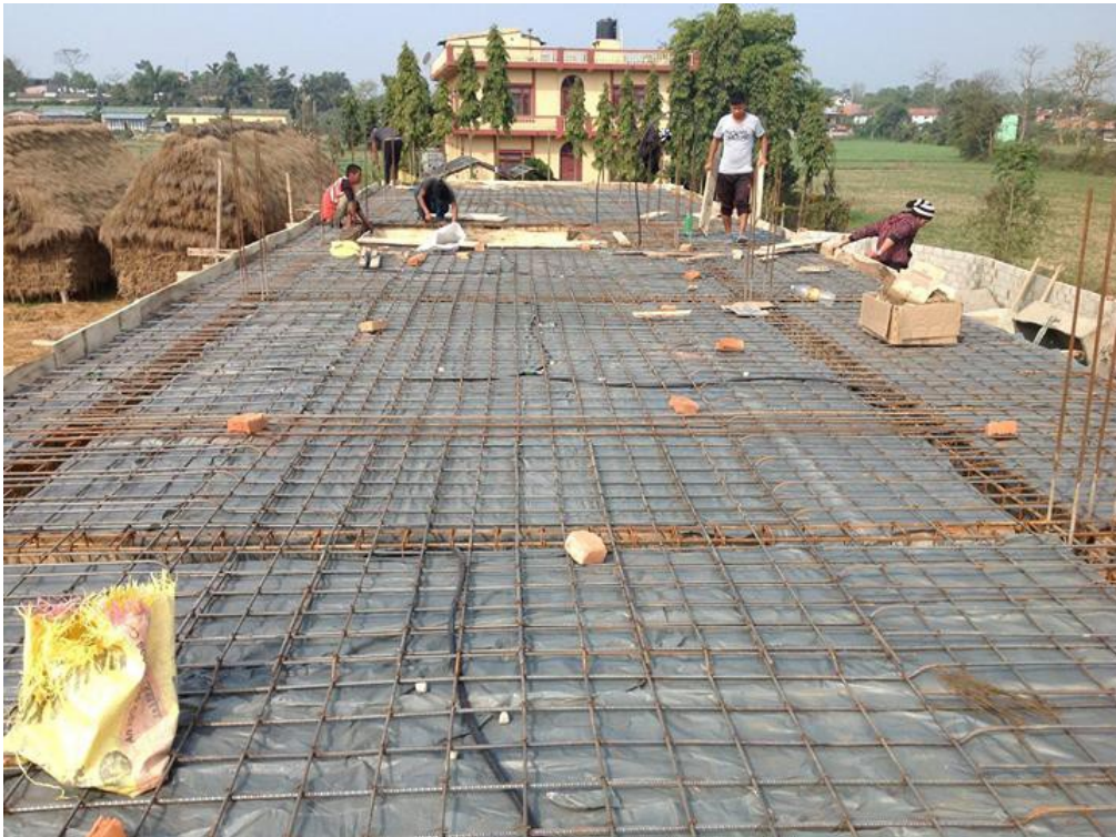
Coulage de la dalle du premier étage. Photo Pemba Sherpa©
