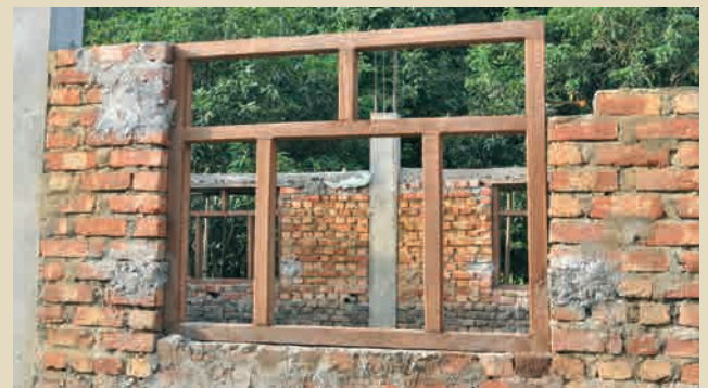
Travaux en cours
